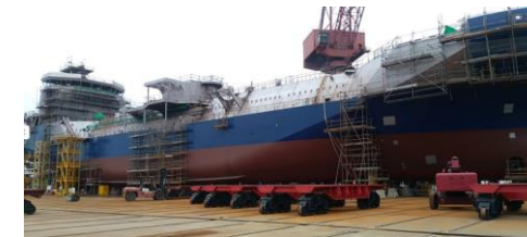
source: Avenir LNG
